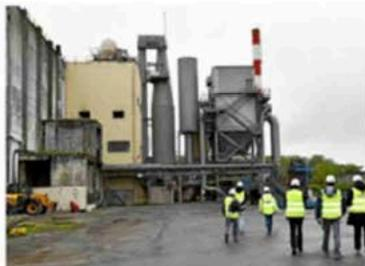
● À la sortie du four, une fois abaissées en température, les fumées sont traitées à la chaux et au charbon actif. Elles passent ensuite par « un filtre à manches » avant de sortir par la cheminée. Un contrôle continu est effectué et deux contrôles externes par an.
